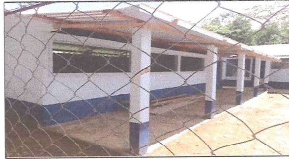
Foto 4: Remozamiento finalizado corredor del aula.
