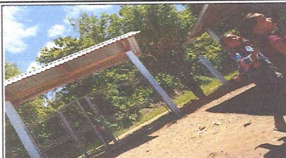
Foto 1: Remozamiento finalizado techo de entrada del establecimiento
