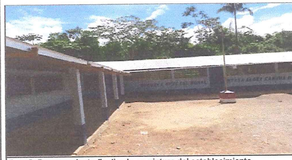
Foto 5: Remozamiento finalizado en pintura del establecimiento.
