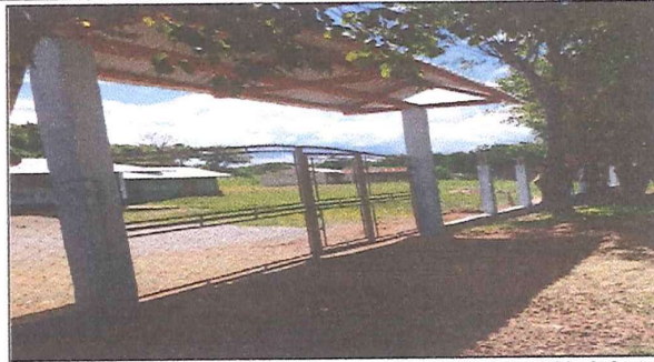
Foto 2: Remozamiento finalizado de porton de entrada del establecimiento
