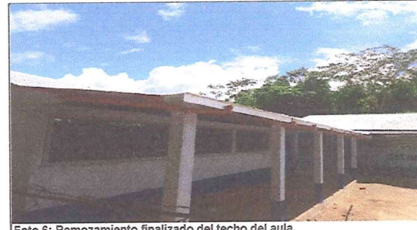
Foto 6: Remozamiento finalizado del techo del aula.
